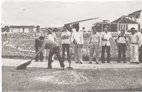
Momento cu diputado Pedro Kelly ta pone schop pa caminda cu recap di camindanan ariba Aruba cu ta den mal estado. Esaki ta solamente un parti di un total di 26 km di caminda cu mester wordo drecha. Tambe lo wordo realiza proyectonan di carreteranan nobo den e añan venidero.
